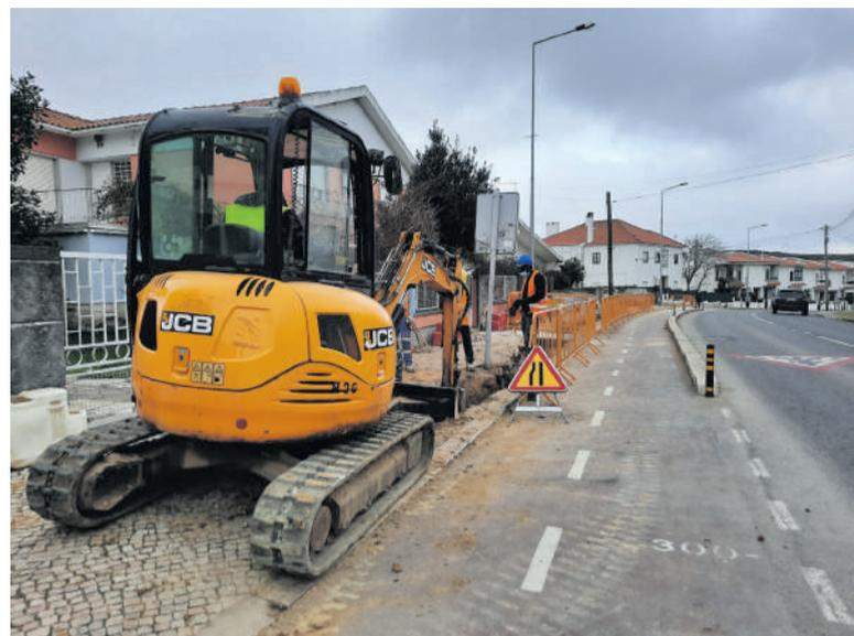
tantes, terá lugar numa extensão de mais de 7 km, com a instalação de condutas de PEAD (Polietileno de Alta Densidade) de diâmetros 90, 110, 160 e 200 mm. As obras contemplam ainda a remodelação de 336 ramais de abastecimento de água.
